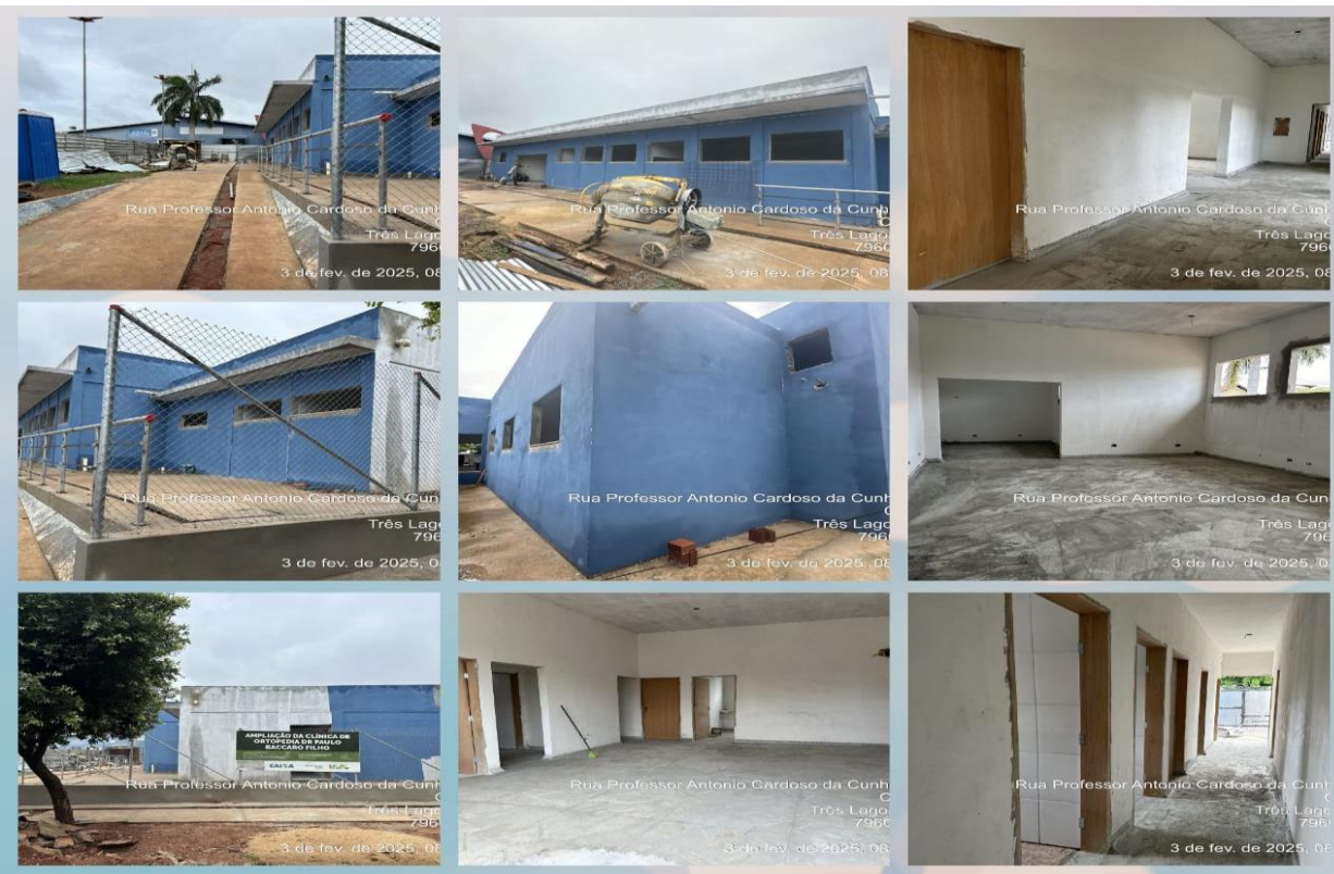
CLÍNICA DE REABILITAÇÃO - 73% da obra concluída
