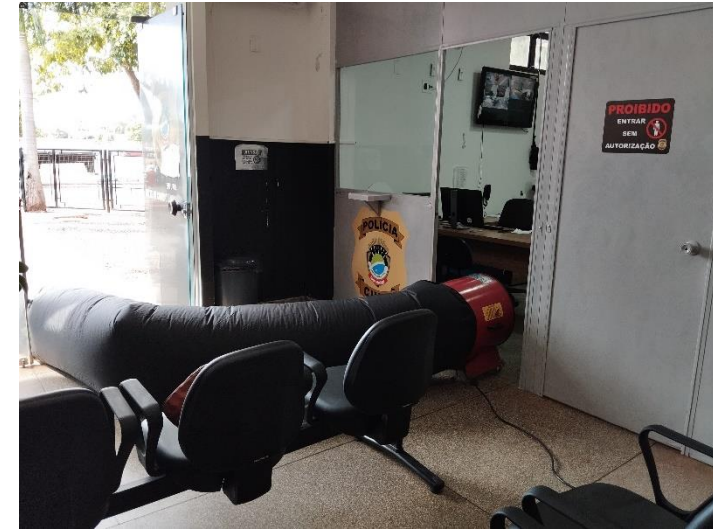
AÇÃO REALIZADA NA POLÍCIA CIVIL, EM CONJUNTO COM O CORPO DE BOMBEIROS E A DEFESA CIVIL, PARA A RENOVAÇÃO DO AR AMBIENTE
